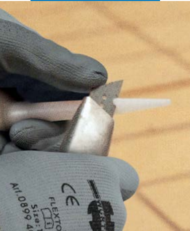
Cortar o bico de acordo com as dimensões da junta
