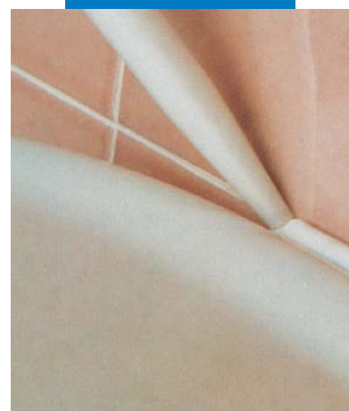
Selagem de sanitários
