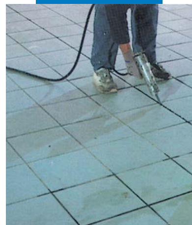
Selagem de um pavimento em cerâmica com Mapesil AC
