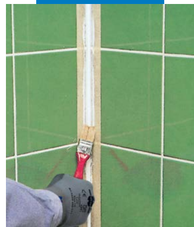
Acabamento da junta com água e sabão com pincel
