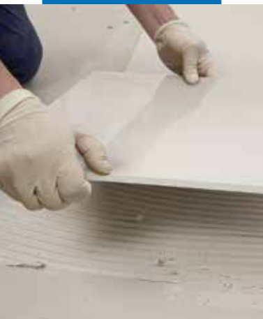
Assentamento de grés porcelânico com Keraflex Extra S1
