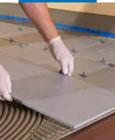
Assentamento de grés porcelânico em sobreposição sobre pavimento existente com Keraflex Extra S1
