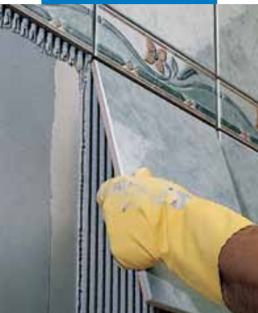
Aplicarea de plăci portelanate pe un perete tencuit
