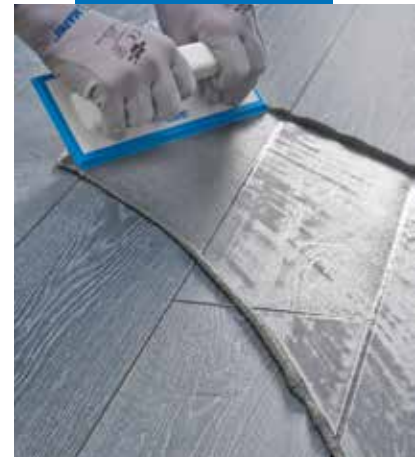
Intinderea chitului Ultracolor Plus cu spatula cauciucata pe o pardoseala din gresie portelanata cu imitatie din lemn
