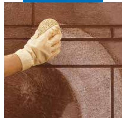
Curatarea si finisarea rosturilor pe perete cu un burete
