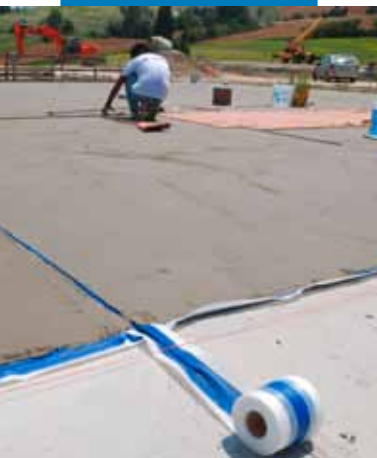
Hidroizolarea șapelor cu Mapelastic și Mapeband
