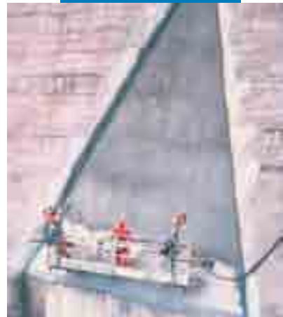
Exemplu de aplicare Mapelastic prin pulverizare la un baraj
