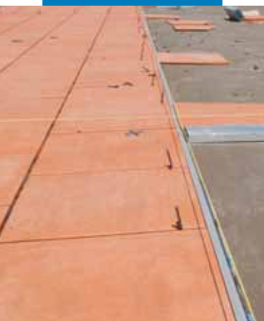
Instalarea plăcilor ceramice cu Kerabond + Isolastic
