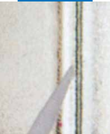
Etansarea profilului U la geam
