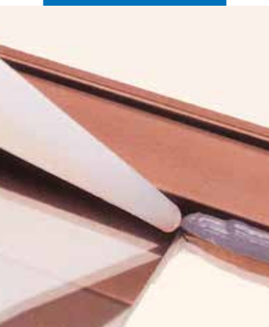
Etansarea cu Mapesil AC a ramei din aluminiu a ferestrei
