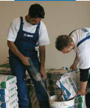
Prepararea Ultraplan Eco - Grădinița Mirabello - Cantù (Como) - Italia
