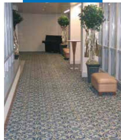
Mocheta instalata pe coridorul unui hotel dupa ce a fost nivelat cu Ultraplan Eco - Hotel Renaissance - Austria
