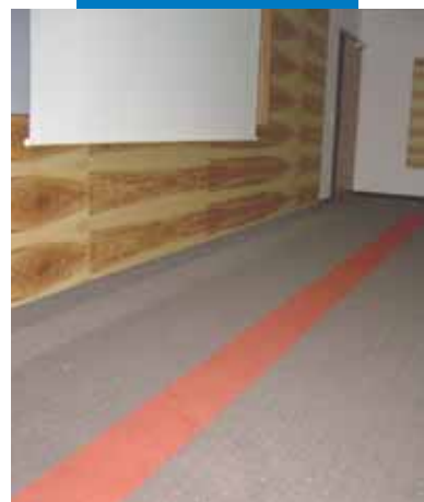
Exemplu de utilizare a amorsei Primer G inainte de turnarea sapei autonivelante Ultraplano Eco si a adezivului Rollcoll pentru lipirea mochetei intr-o camera de hotel - Villa Hotel Castellani - Austria
