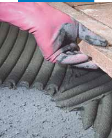
Montarea plăcilor de teracotă realizate manual, pe o suprafață neuniformă
