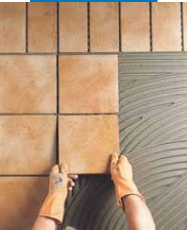
Montarea la exterior a plăcilor de klinker
