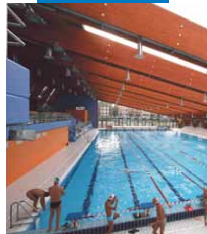
Bazen hidroizolovan Mapelastic-om: Scarioni Rekreativni Centar, Milano - Italija
