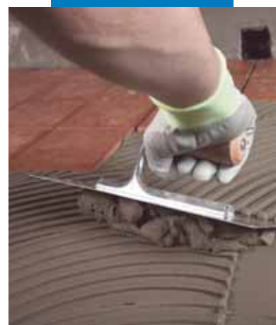
Nanošenje Granirapid-a na terasu hidroizolovanu Mapelastic-om
