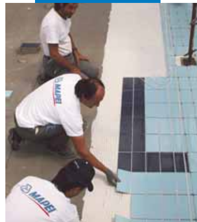
Polaganje keramičkih pločica na Mapelastic u bazenu
