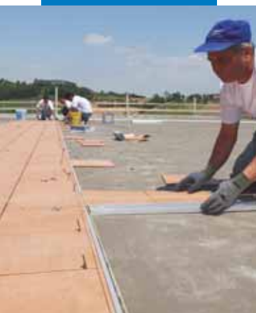
Polaganje keramike sa Kerabond-om + Isolastic
