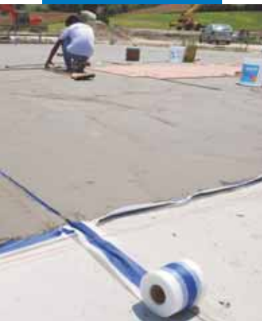
Hidroizolacija estriha sa Mapelastic-om i Mapeband-om
