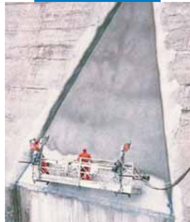
Primer Mapelastic -a nanesenog na branu špricanjem
