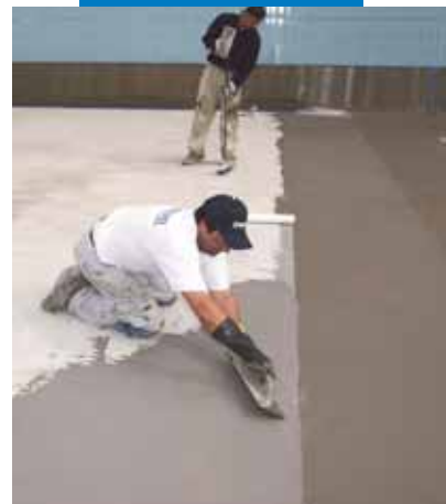
Hidroizolacija bazena Mapelastic-om
