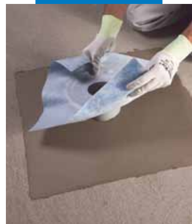
Postavljanje vertikalnih odvoda na Mapelastic
