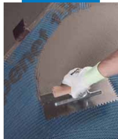
Ugradnja Mapelastic-a na Mapenet 150
