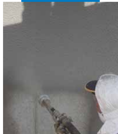
Primer Mapelastic -a nanesenog na vijadukt špricanjem
