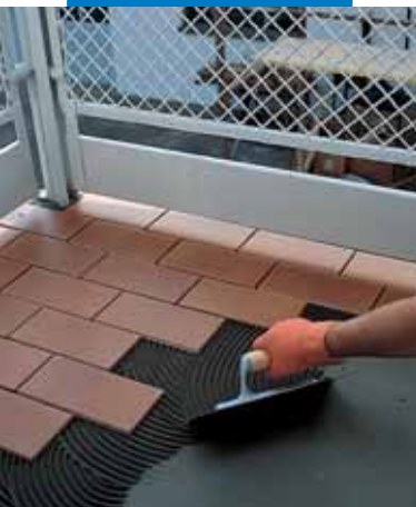
Укладка плитки на клей Granirapid на балконе, гидроизолированным с помощью Mapelastic
