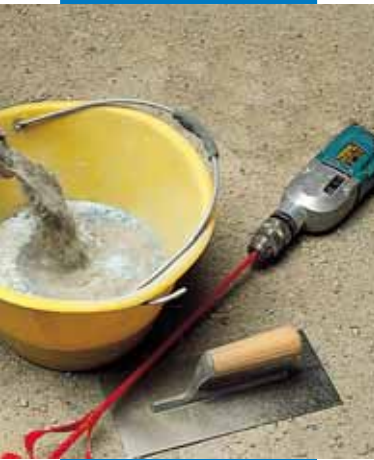
Замешивание Mapelastic миксером
