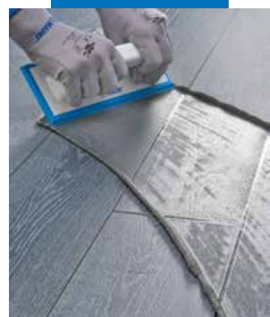
Fogning av Ultracolor Plus med gummispackel på klinker med trä-stuktur
