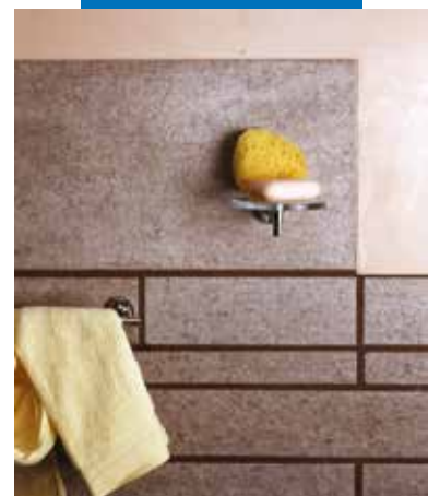
Vägg fogad med Ultracolor Plus
