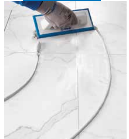
Applicering av Ultracolor Plus på marmor på gummispäckel
