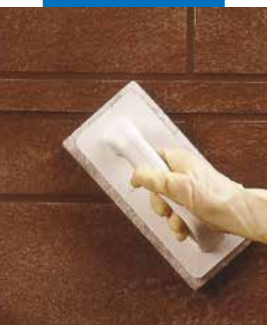
Påföring av Ultracolor Plus på vägg med gummispackel
