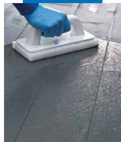
Rengöring av kakelfogar med Scotch-Brite® när produkten delvis har härdat
