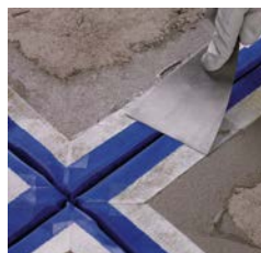
SLIKA 2: Vtisnjanje MAPEBAND (križni elementi) v sveži sloj MAPELASTIC-a.
