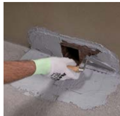
SLIKA 2: Preplastitev DRAIN FRONT elementa z epoksidno smolo ADESILEX PG1/PG4.
