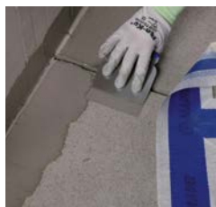
SLIKA 1: Nanos prvega sloja MAPELASTIC-a.
