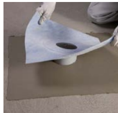
SLIKA 2: Vgradnja DRAIN VERTICAL/LATERAL odtočnega elementa z gumirano manšeto.
