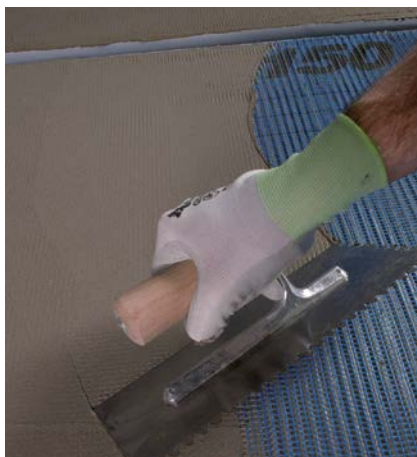
SLIKA 2: Vgradnja armirne mrežice MAPENET 150 in preplastitev z MAPELASTIC-om.
