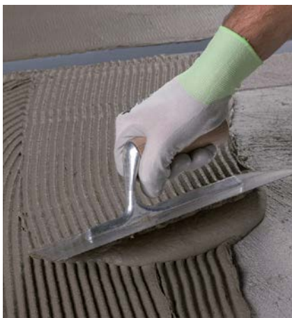
SLIKA 1: Nanos prvega sloja MAPELASTIC-a.
