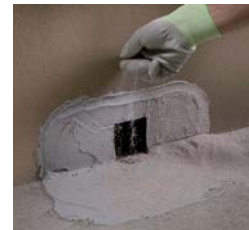
SLIKA 3: Posutje sveže mešanice ADESILEX PG1/PG4 s suhim kremenčevim peskom QUARZO.
