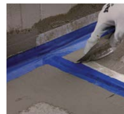
SLIKA 3: Preplastitev sivega dela (filca) MAPEBAND traku z MAPELASTIC-om.
