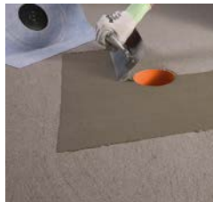
SLIKA 1: Nanos prvega sloja MAPELASTIC-a.
