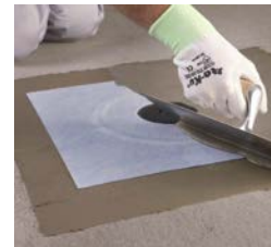
SLIKA 3: Preplastitev gumirane manšete DRAIN VERTICAL/LATERAL elementa z MAPELASTIC-om.
