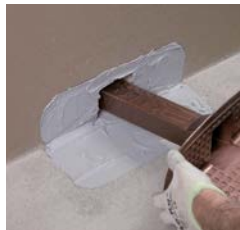
SLIKA 1: Vgradnja DRAIN FRONT odtočnega elementa v dvokomponentno epoksidno smolo ADESILEX PG1/PG4.
