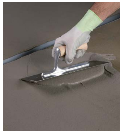
SLIKA 3: Nanos drugega sloja MAPELASTIC-a (po preteku 4-6 ur).
