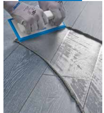
Nanášanie Ultracolor Plus s použitím gumovej stierky na porcelánovej dlažbe s imitáciou dreva
