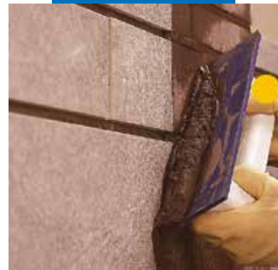
Nanášanie Ultracolor Plus na stenu s gumovou stierkou
