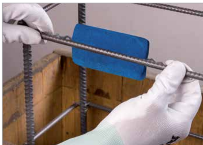
Укладка Mapeshield I на новую конструкцию
