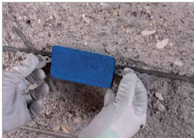
Укладка Mapeshield I на ремонтируемую конструкцию
