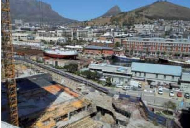
Le fondazioni viste dall'alto del Silo 1. I prodotti Polyglass sono stati utilizzati per impermeabilizzare a vari livelli.
