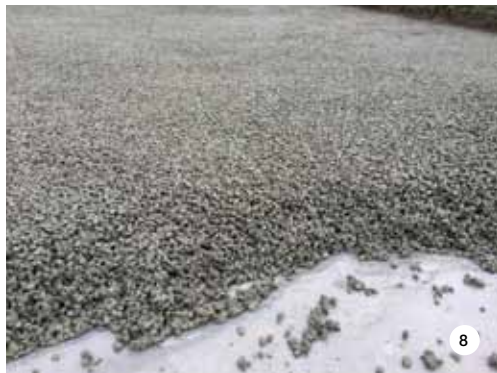
FOTO 5. Flow-layer realizzato con la stesa di manto MAPEPLAN PE.
