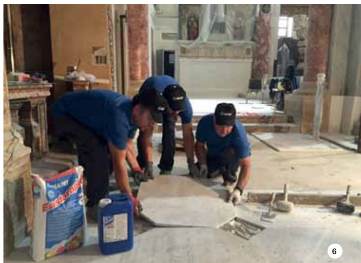
FOTO 5. Intervento strutturale di rinforzo statico della cupola del presbitero con il sistema MAPEWRAP. FOTO 6. La pavimentazione costituita da elementi in Marmo di Carrara e tozzetti in Grigio Bardiglio è stata posata con l'adesivo cementizio bicomponente ELASTORAPID.
