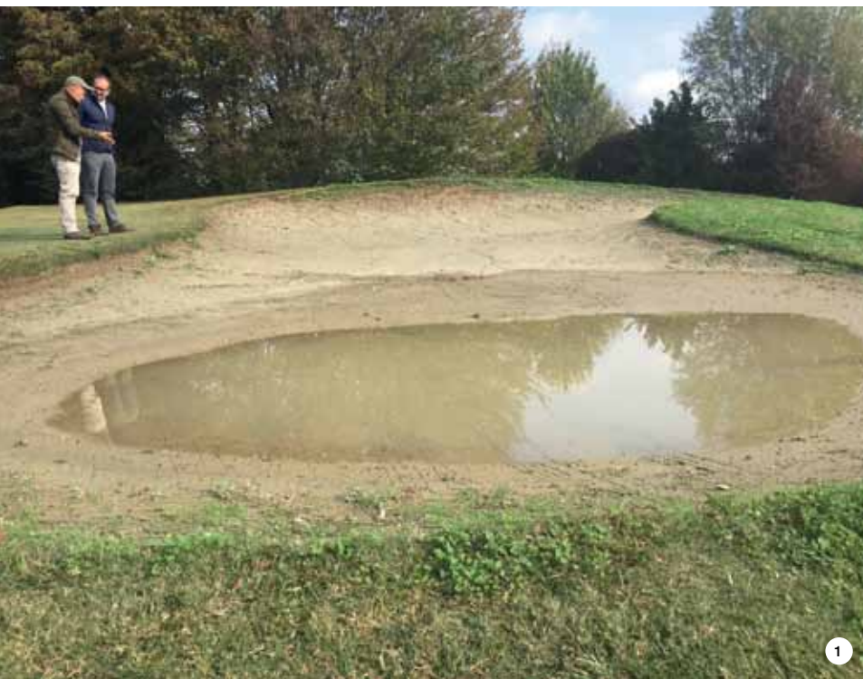
FOTO 1. Tipico esempio dell'annosa problematica legata allo scarso drenaggio del bunker.
