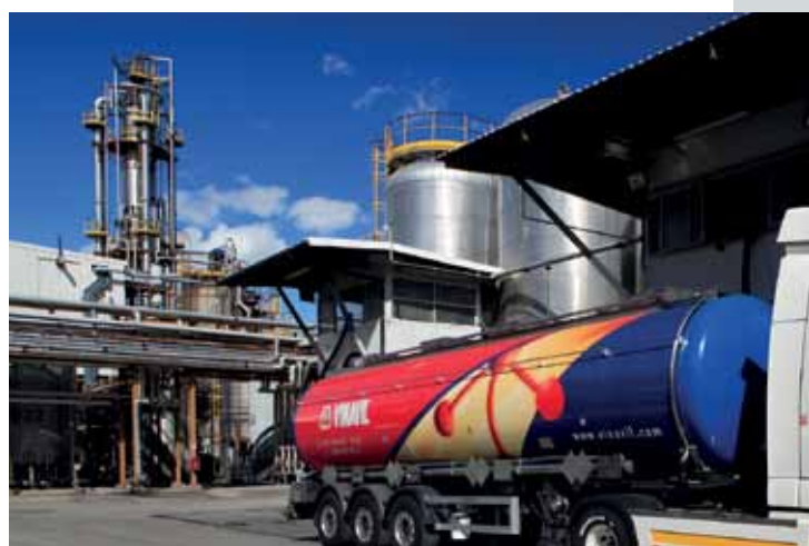
FIG. 4. Carico del prodotto sfuso e, sullo sfondo a sinistra, il reattore tubolare per la copolimerizzazione in pressione del vinile acetato con l'etilene.
