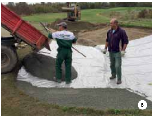
FOTO 5. Flow-layer realizzato con la stesa di manto MAPEPLAN PE.
