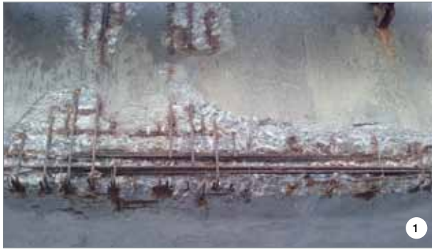
FIGURA 1. Esempio di elemento in calcestruzzo armato degradato dalla corrosione dei ferri d'armatura.
