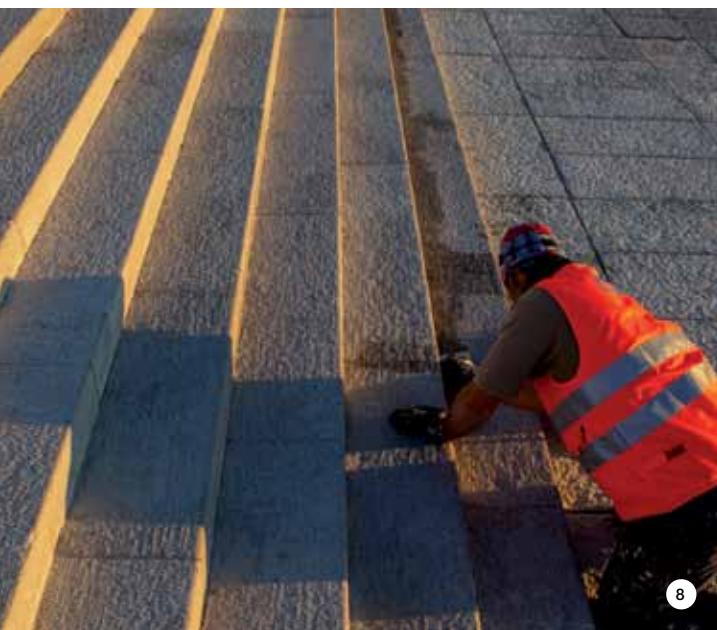
FOTO 8 . Gli zoccolini sono stati posati con KERAQUICK MAXI S1.
