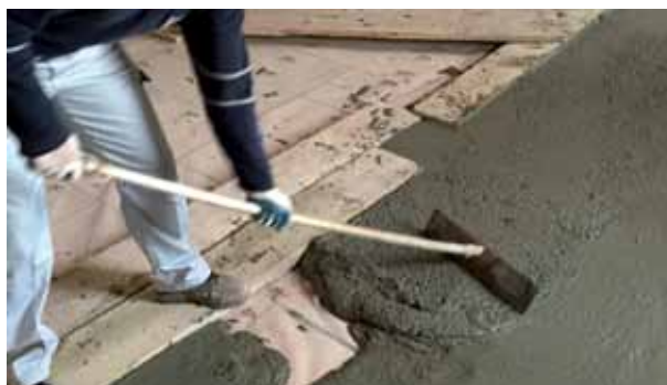
Rinforzo estradossale di solaio in legno effettuato con PLANITOP HPC FLOOR.
