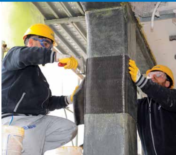
Rinforzo di un nodo trave-pilastro con MAPEWRAP C SYSTEM.
