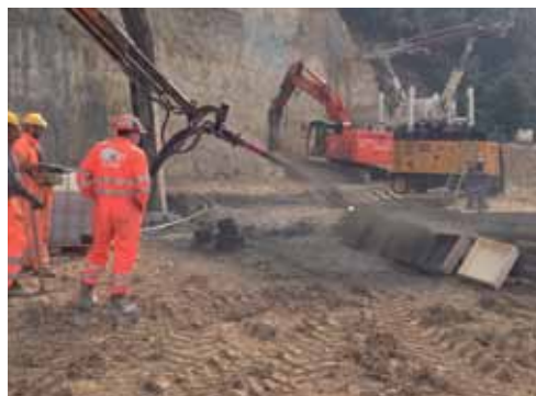
Prove spritz nella galleria Sant'Urbano
