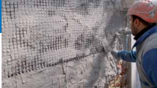
Applicazione del rinforzo in basso spessore per incrementare la resistenza a taglio-trazione di maschi murari, con il SISTEMA FRCM.
