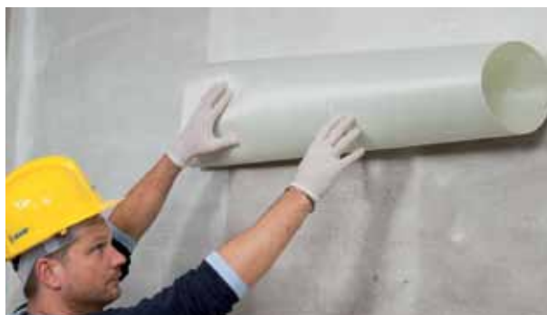
MAPEWRAP EQ NET, tessuto bidirezionale in fibra di vetro apprettato per il presidio sismico delle partizioni secondarie degli edifici.
