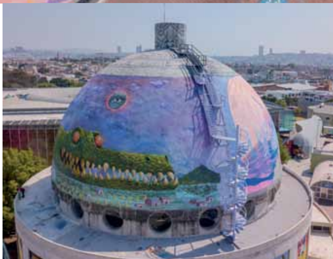
CENTRO CULTURALE MANUEL GÓMEZ MORÍN. A Queretaro, la Cúpula del Péndulo de Foucault (2.000 m 2 ) che sovrasta la biblioteca e i muri perimetrali del Centro culturale sono stati impermeabilizzati con AQUAFLEX TECHOS FIBRADO. La cupola è stata poi decorata da artisti locali e internazionali.
