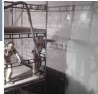
**Purtop 1000** è una **membrana impermeabilizzante** poliureica a spruzzo e priva di solventi, che consente l'immediata impermeabilità e pedonabilità delle superfici. Può essere applicato su diverse superfici, creando uno strato elastico, durevole e resistente.
