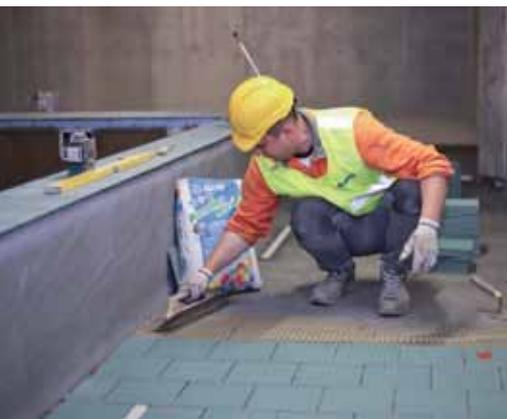
Alcune fasi costruttive della palazzina del Mapei Football Center: in alto, la realizzazione delle superfici con MAPEFLOOR I 320 SL CONCEPT e, in basso, la posa delle piastrelle con KERAFLEX MAXI S1.
