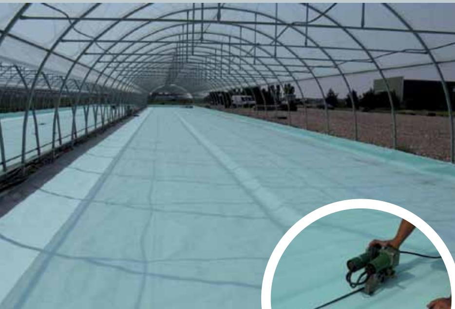
Le vasche di contenimento dell'acqua sono state impermeabilizzate con il manto sintetico MAPEPLAN T WT.
