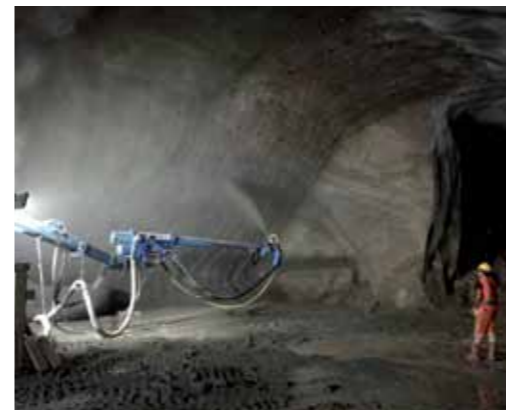
IN ALTO. Un'immagine del castello e dell'uscita pedonale del parcheggio e l'interno del parcheggio a lavoro ultimato. QUI SOPRA. Il calcestruzzo utilizzato è stato confezionato con DYNAMON SR 912 CH. Una fase di spruzzo. Come accelerante di presa è stato scelto MAPEQUICK AFK 777 T.
