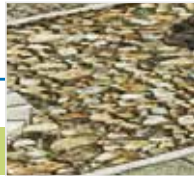
Montaż kamieni na zakładkę
