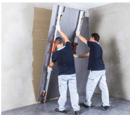
Укладка плитки на стену
