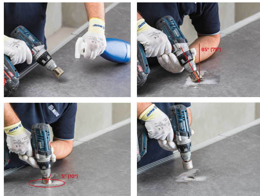
Порядок действий по созданию круглого отверстия
