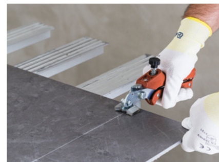
Разламывание плитки с помощью щипцов для надлома
