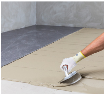
Клей наносится на основание и на плитку в одинаковом направлении
