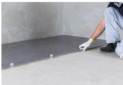
Установка разделителей в требуемое положение
