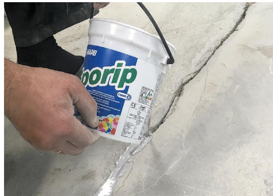
Заливка трещин в основании с помощью Eporip
