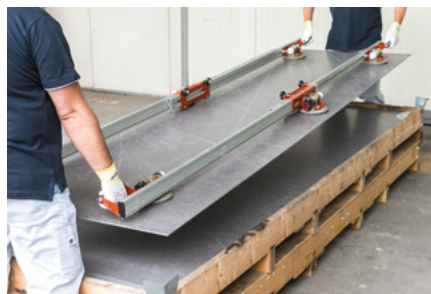
Правильное перемещение плитки
