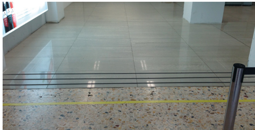
Укладка плитки поверх существующих полов
