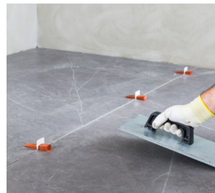
Простукивание плитки вручную или с помощью вибропанели
