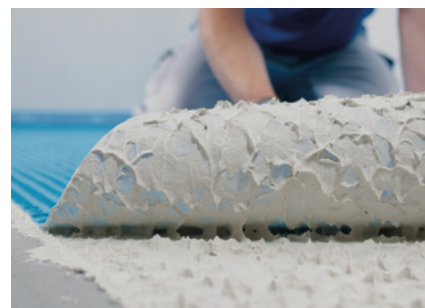
Процесс укладки Mapeguard UM 35
