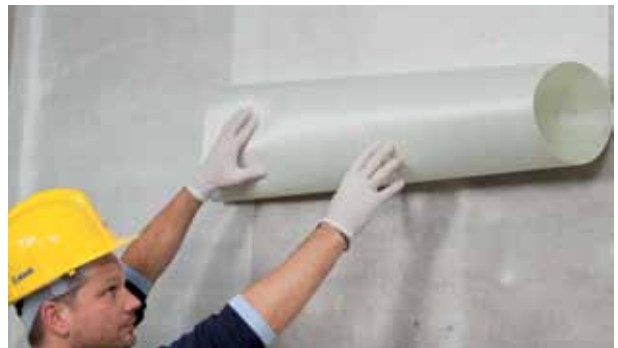
Applying MAPEWRAP EQ NET, a component of the MAPEWRAP EQ SYSTEM.
