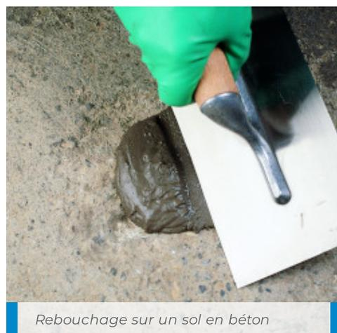
Rebouchage sur un sol en béton
