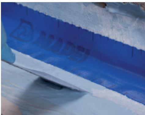
Application de Mapeband dans la jonction sol/mur avec Mapelastic AquaDefense
