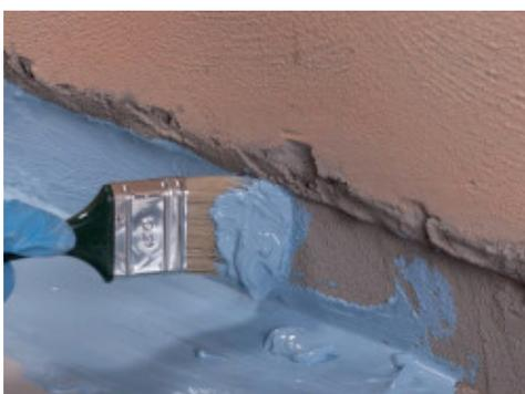
Application au pinceau, de Mapelastic AquaDefense à la jonction sol/mur, avant l'application de Mapeband PE 120
