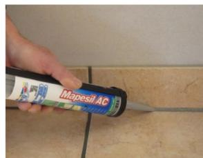
Fig 1 : Traitement de la jonction avec un receveur de douche posé sur le support maçonné
