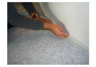
Coller et maroufler la bande de pontage de manière à recouvrir les joints entre les lés. Utiliser également la bande de pontage pour calfeutrer les raccords des bandes périphériques entre elles. Cette opération vise à isoler la mini chape du support pour éviter les risques de ponts phoniques.
