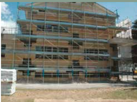
5 | Rinforzo nodo trave-colonna mediante tessuti MapeWrap C - "Progetto Scuole" - L'Aquila
