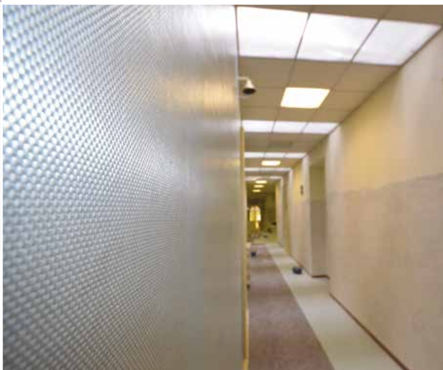
2 | Antiribaltamento delle tramezzature mediante posa di MapeWrap EQ System Liceo Dante Alighieri - Gorizia
