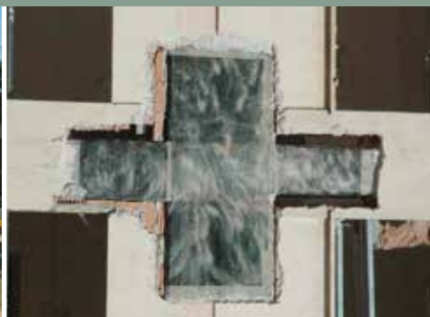
4 | Rinforzo a taglio dei maschi murari con Mapegrid G220 e Planitop HDM Maxi - Scuola primaria Sant'Agostino - Ascoli Piceno
