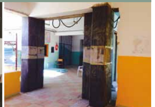
6 | Rinforzo a taglio di pilastri mediante tessuti MapeWrap C - Scuola elementare, Frazione Mirto - Crosia (CS)
