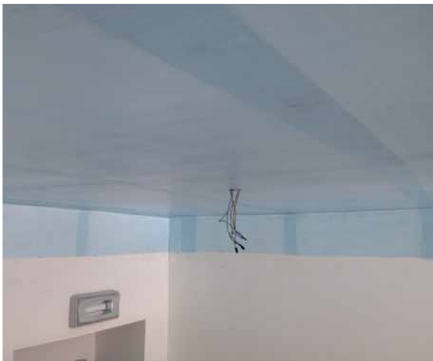
1 | Sistema antisfondellamento dei solai mediante MapeWrap EQ System Istituto comprensivo statale "Madre Teresa di Calcutta" a Toro (CB)
