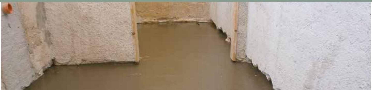
3 | Rinforzo estradossale di solaio mediante getto di Planitop HPC Floor - Scuola Mons. Giovanni Bacile - Bisacchino (PA)
