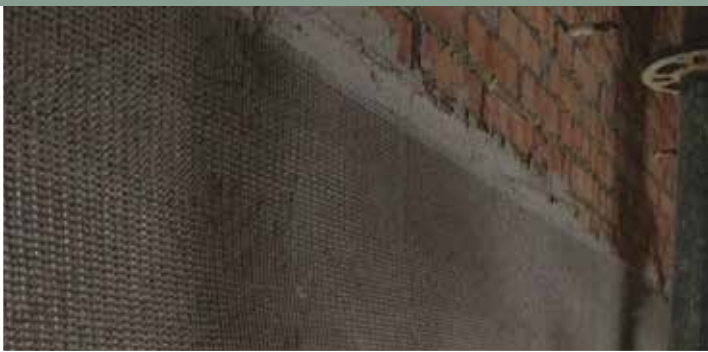
4 | Rinforzo a taglio dei maschi murari con Mapegrid G220 e Planitop HDM Maxi - Scuola primaria Sant'Agostino - Ascoli Piceno
